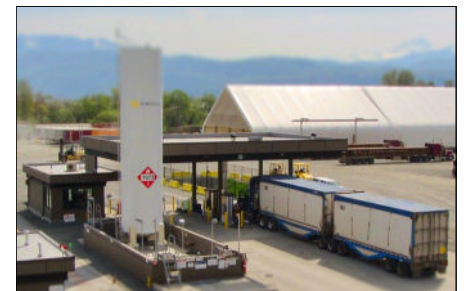
LNG Refueling Station
